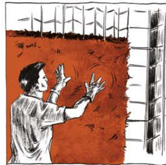
LA TERRE EST LISSÉE À LA MAIN.
