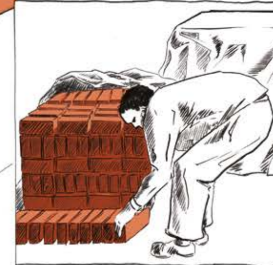
QUAND ILS SONT STABILISÉS, LES BLOCS SONT EMPILÉS DANS UNE ZONE DE STOCKAGE POUR EFFECTUER UNE CURE HUMIDE SOUS BÂCHE D'ENVIRON 28 JOURS.
