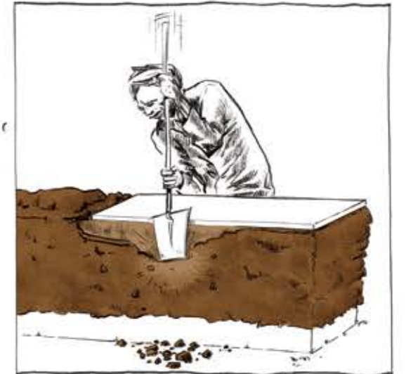
LES DEUX FACES DU MUR SONT TAILLÉES À L'AIDE D'UNE BÈCHE OU D'UN OUTIL TRANCHANT.
