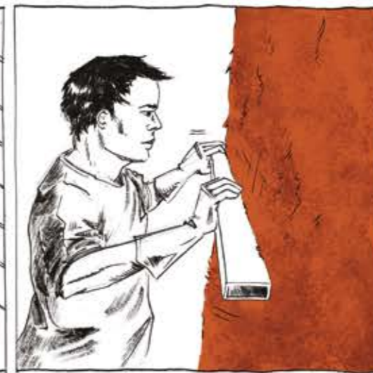
LA PLANÉITÉ EST VÉRIFIÉE À L'AIDE D'UNE GRANDE RÈGLE MÉTALLIQUE.
