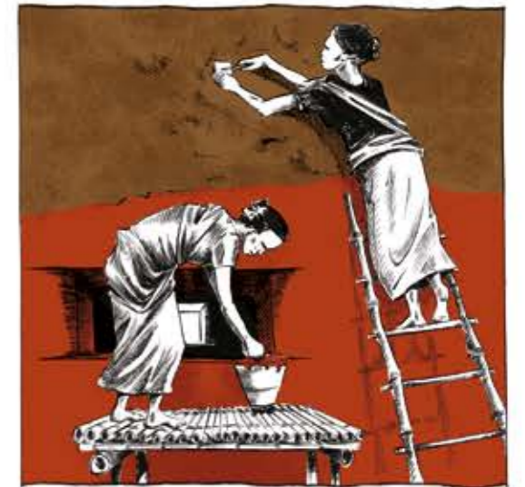
LE MUR EST DÉBARRASSÉ DES BOUTS DE PAILLES QUI DÉPASSENT AFIN DE PRÉPARER UNE PAROI PLANE. SI LA SURFACE DOIT ÊTRE ENSUITE, ELLE EST PRÉPARÉE PAR SCARIFICATION OU GRATTAGE POUR PERMETTRE UN BON ACCROCHAGE.
