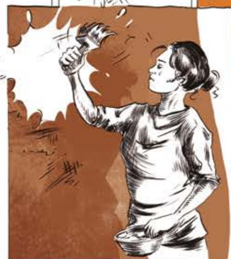
LE SUPPORT DOIT ÊTRE PRÉPARÉ AVANT L'APPLICATION DE L'ENDUIT : LE MUR EST GRATÉ POUR UNE MEILLEURE ADHÉSION DU MÉLANGE, PUIS HUMIDIFIÉ.
