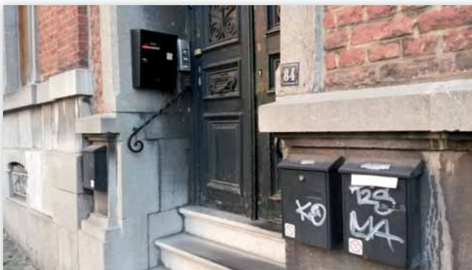
Entrée d'une maison de maître divisée en plusieurs logements (Liège)
